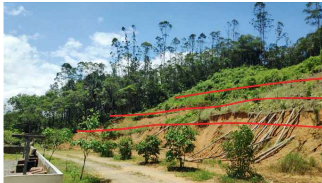
Detalhe do monitoramento realizado | Foto: Geotrackto
