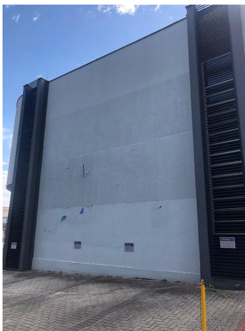
Foto 1: Textura soltando na parede externa
